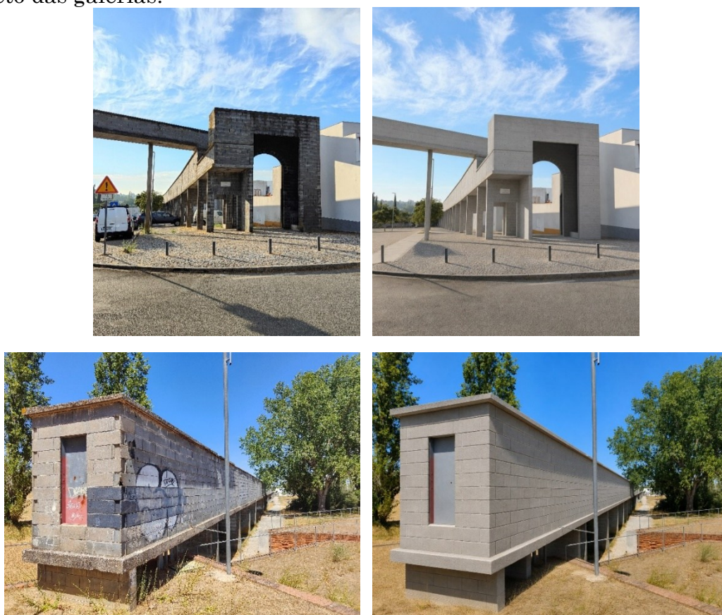
Figs. 52, 53, 54 e 55 – Convergência das condutas no topo da Avenida da Malagueira e Topo inicial de conduta no Jardim dos Socalcos, com os blocos de betão grafitados e ou degradados, na atualidade, à esquerda, e como se imagina no amanhã, com devido tratamento do betão, à direita (imagens manipuladas com recurso a ferramentas de IA)
