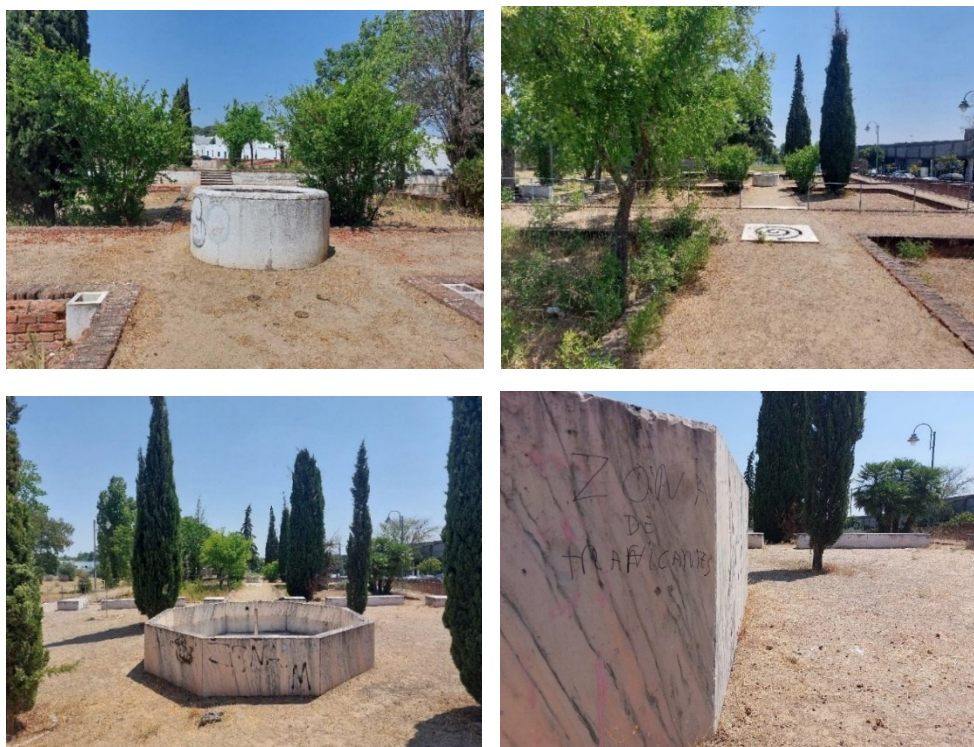
Figs. 14, 15, 16 e 17 – Estruturas hidráulicas do sistema de água do Jardim dos Socalcos e grafiti («Zona de traficantes») indicativo de problemas de marginalização do espaço
