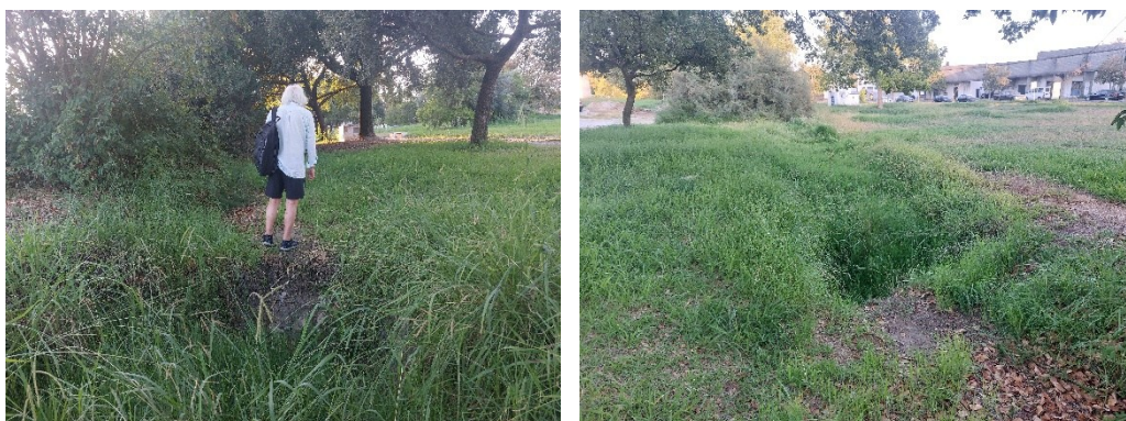
Figs. 82 e 83 – Exemplos atuais de assoreamento da linha de água da Ribeira da Torregela, com interrupção de trabalhos anteriores de desassoreamento e aprofundamento do leito.
