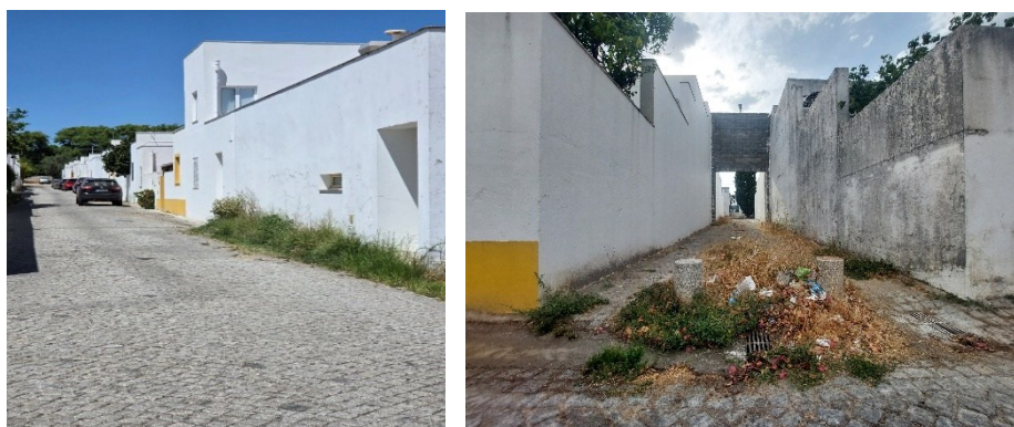
Fig. 22 e 23 – Acumulação de ervas nas valetas e regueiras dos arruamentos
